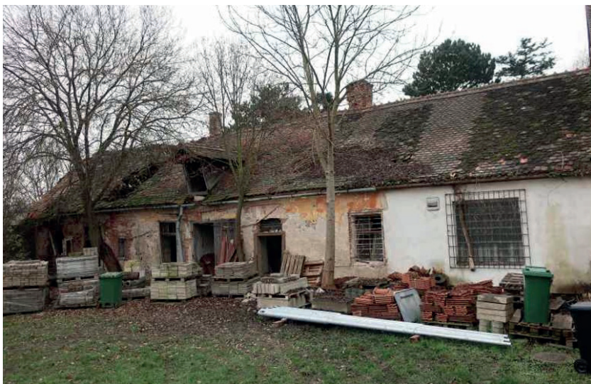
Zámek v Podolí. Současný stav dvorního traktu, který byl v roce 1828 přestavěn na byt drába a vězení. (archiv autora)
