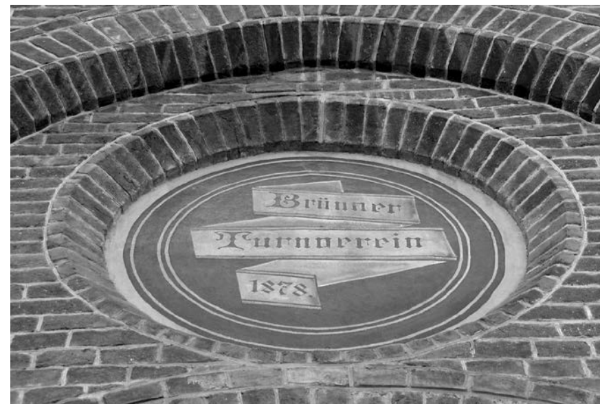
Detail fasády „turnhaly“ s vyznačením letopočtu obnovy po požáru. (foto: NPÚ, M. Procházková)
