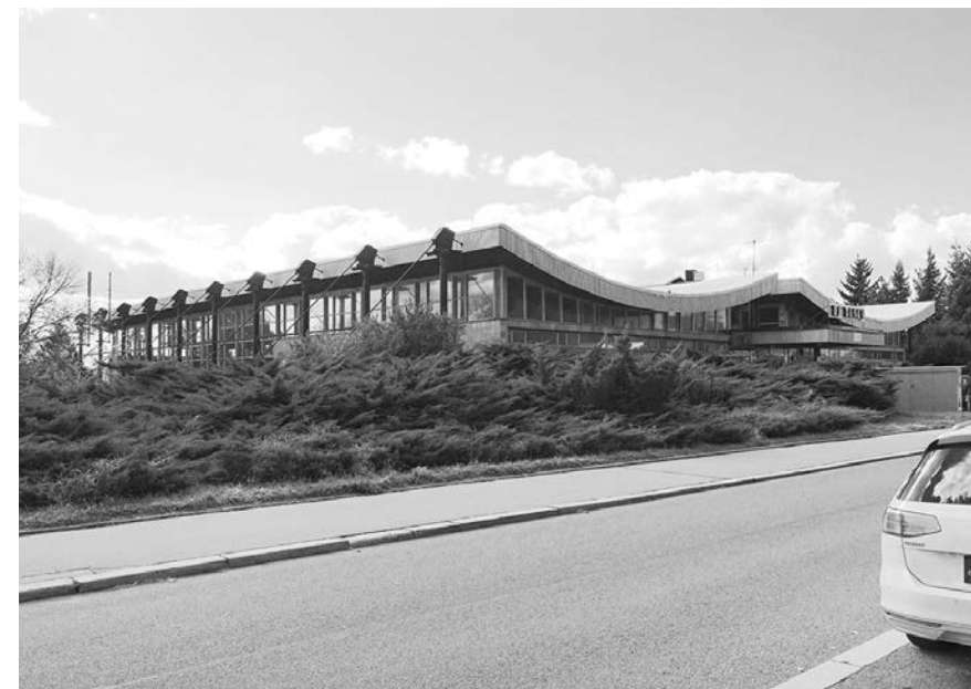
Víceúčelová hala TJ Tesla. (foto: NPÚ, P. Svoboda)
