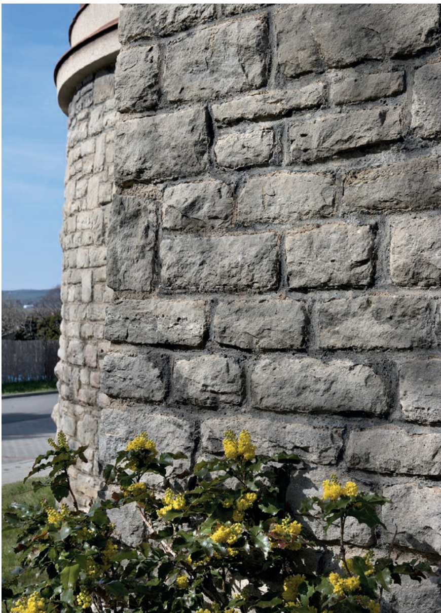
Jihozápadní nároží kostela Nejsvětějšího Srdce Ježíšova v Blažovicích, při jehož stavbě byl využit místní litavský vápenec nazývaný také řasový, neboť se na jeho vzniku významně podílely stélky červených řas rodu Lithothamnium . (foto: P. Halas)
