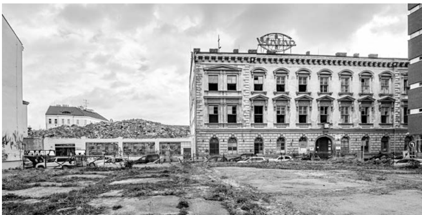
Devastovaný bývalý Bochnerův palác s ruinami továrny Bratři Stiassni. Stav v dubnu 2017. (foto: M. Zavadil)
