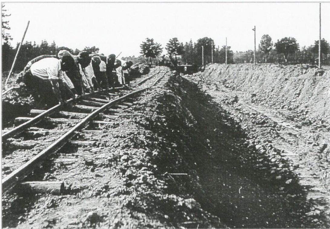
PŘESOUVÁNÍ KOLEJÍ ÚZKORozCHODNÉ DRÁŽKY PŘI BUDOVÁNÍ STROJÍREN ŽĎAS VE ŽĎÁRU NAD SÁZAVOU (VŠECHNY FOTOGRAFIE K ČLÁNKU M. VAŇKA POCHÁZEJÍ Z AUTOROVY SBÍRKY).
