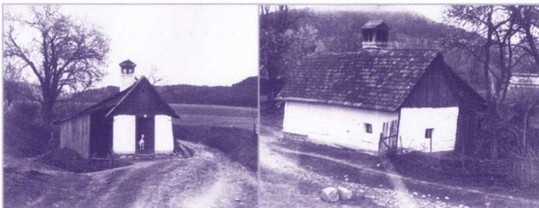
OBR. 5, VLEVO NAHOŘE: STAV DOMU V ROCE 1947, NPÚ ÚOP V BRNĚ, SIGN. 44 093
