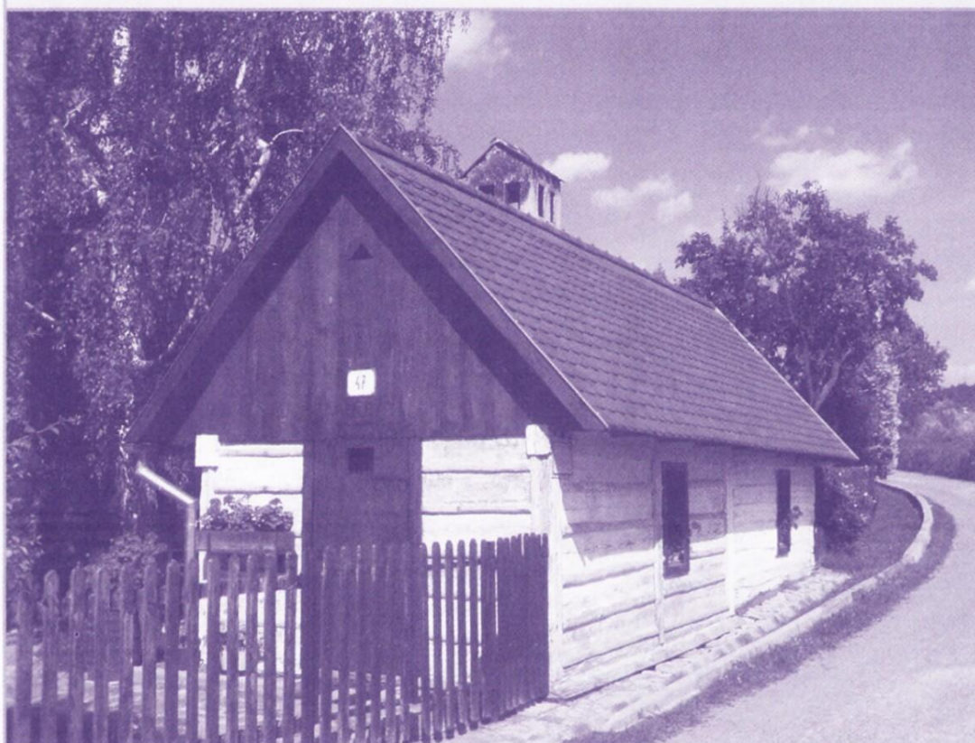
OBR. 10: STAV PO OPRAVĚ, 2009 (FOTO JITKA MATUSZKOVÁ)
