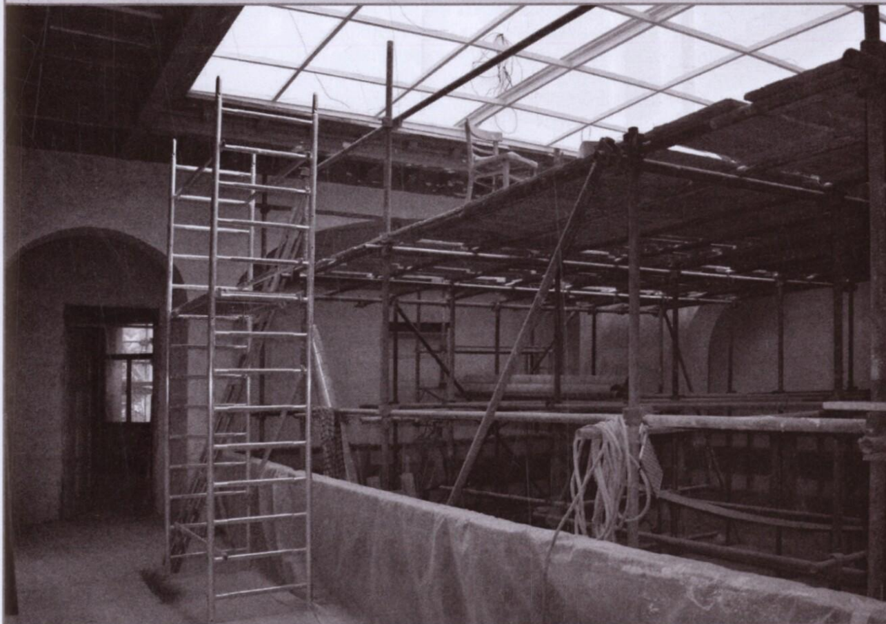
DOLE ZÁBĚR Z OCHOZU V PRVNÍM PATŘE VILY, NA NĚMŽ JE PATRNÁ OPRAVA VELKÉHO STŘEŠNÍHO SVĚTLÍKU NAD HALOU, DUBEN 2014 (FOTO PETR MRKVIČKA)
