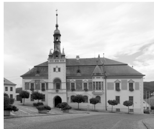
Radnice v Tišnově, č. p. 111, nám. Míru, hlavní průčelí, včetně přístavby z let 2002–2003. (foto: Národní památkový ústav v Brně, M. Zavadil)
