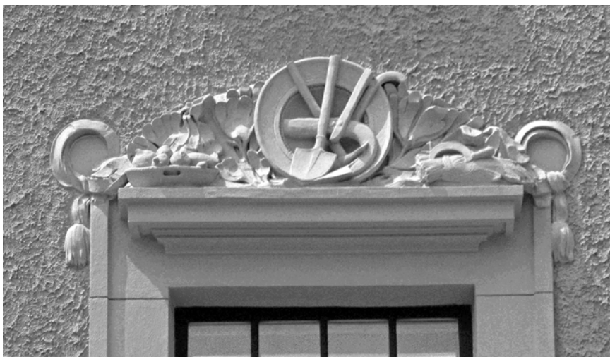
Hotel Květnice, č. p. 120, průčelí do nám. Míru, suprafenestra se štukovým reliéfem. (foto: J. Krejčí)
