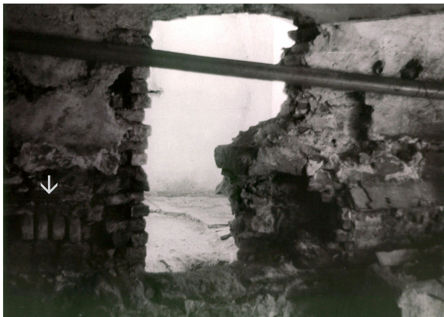
Západní strana věže, pohled z domu, v popředí je patrná soklová úprava stěny a lišta z cihelných tvarovek, 1981, obr. 9. (Muzeum v Ivančicích)
