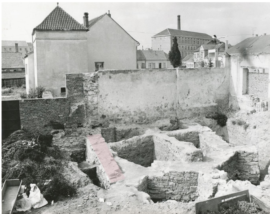
Pohled na základy presbytáře, na nichž je patrný pozdější základ stodoly, 1980, obr. 12. (Muzeum v Ivančicích)
