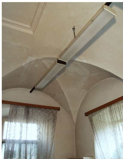
Klenba s koutovými výsečemi v nárožní místnosti č. 104 levého traktu přízemí. (foto: P. Borský, 2012)
