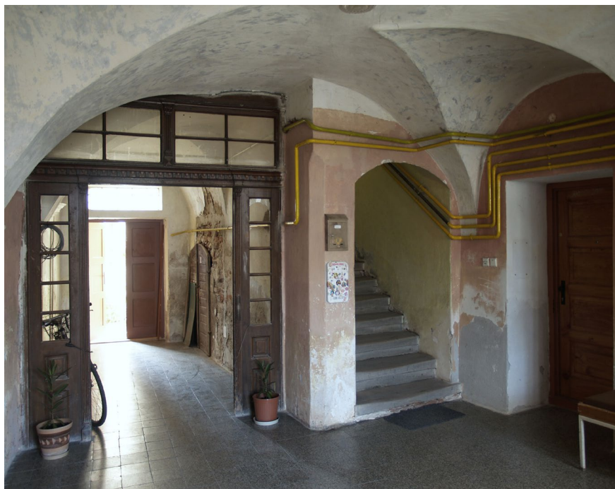
Dolní síň domu Krumlovská 298/8 v Ivančicích se schodištěm do patra. Dům je datován letopočtem na portálu do roku 1615. (foto: P. Borský, 2012)
