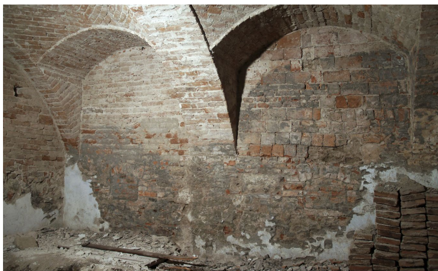
Ze středověké sklepní šíje č. 06 vede k západu úzký a převýšený průchod do sklepa č. 07, jehož zadní čelo tvoří pouze hliněná stěna. Na sklopeném záklenku průchodu jsou otisky bednění a záklenek strmě stoupá ke sklepu č. 07. V místě barokního sklepa č. 07 byla středověká dřevohlinitá prostora komora s podlahou ve vyšší úrovni. (foto: P. Borský, 2012)
