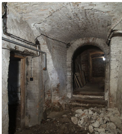
Sklep č. 04 se studnou v pohledu ke vstupu ze středověké sklepní šíje č. 06. Středověká plochostropá prostora je dodatečně zaklenutá kamennou valenou klenbou s cihelnou výsečí nad vstupem. Předpokládaný kamenný portálek nahradilo ostění z cihel. (foto: P. Borský, 2012)
