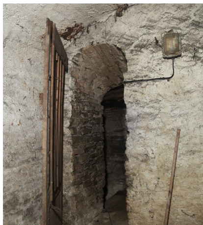
Barokní sklep č. 05 pod pravým traktem. Tento sklep byl v západní části dispozice vyhlouben dodatečně s podezděním základů středověké stavby. (foto: P. Borský, 2012)
