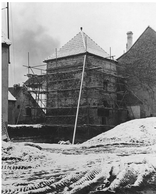
Totéž místo v době opravy věže, na štítové stěně domu č. 10 je čerstvý otisk zbourané přístavby. V zahradě domu je vidět štít dvorního stavení a část střechy dnes již zbourané renesanční stavby, v době působení sboru vyzdobené nápisy, 1955, obr. 4b. (Muzeum v Ivančicích)
