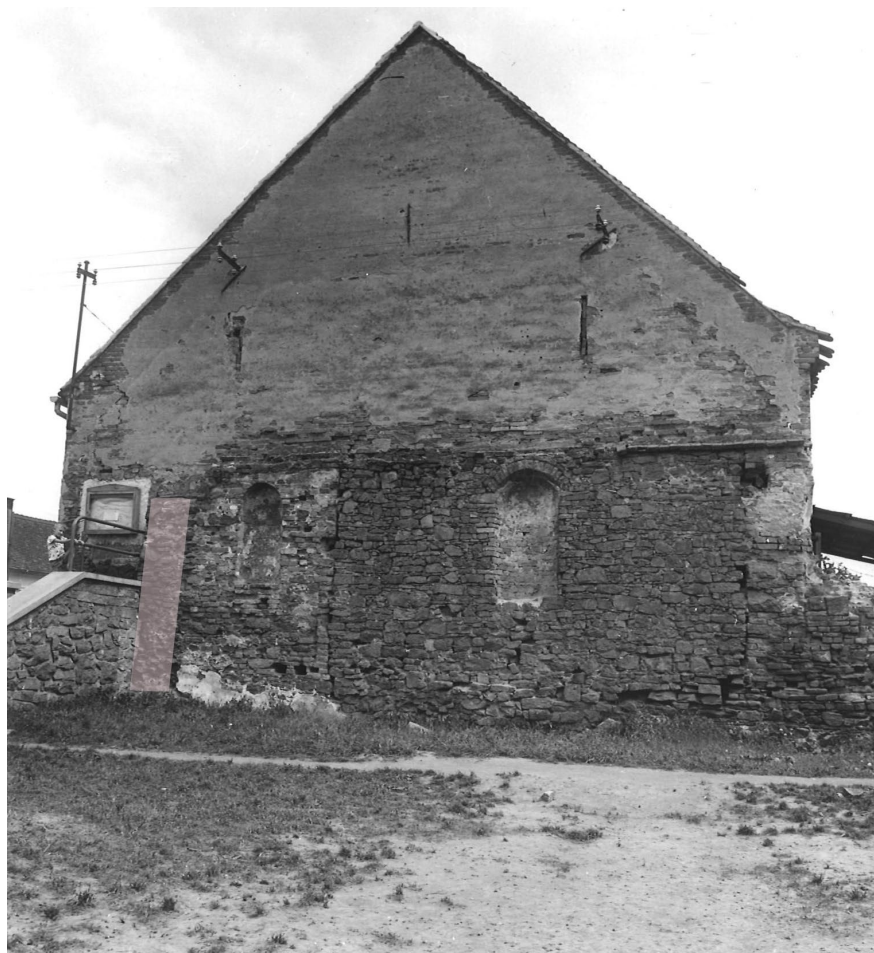
Stodola se začleněnou zdí modlitebny, vedle schodiště je dobře patrný pozůstatek severní zdi modlitebny, na druhé straně destruovaná část zdi, 1968, obr. 11. (Národní památkový ústav)
