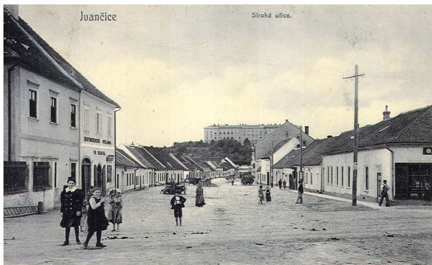
Dům č. p. 366 na historické pohlednici z doby před rokem 1917 (prošlo poštou 7. února 1917). Patrná je odlišná úprava fasád obou dílů majetkově rozděleného domu. Na průčelí pravého dílu (dříve č. p. 154) jsou nápisy SEIFENSIEDEREI MYDLÁRNA a jméno Fr. Drapala. V přízemí je vedle vrat v průjezdu krámské okno a za ním je při nároží menší okno. (soukromá sbírka)
