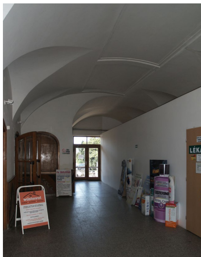
Předělená dolní síň č. 101 v pohledu ke dvoru, vlevo zrušené renesanční schodiště do patra. (foto: P. Borský, 2012)
